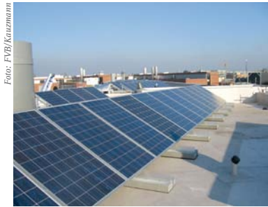
Foto: FVB/Kauzmann Auf dem Dach des IKZ wurden kristalline Solarmodule installiert.
