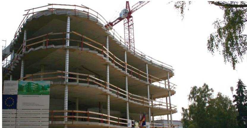
Der Rohbau lässt die Form schon erahnen: Das neue Genomhaus auf dem Campus Buch ist ein gemeinsames Projekt von MDC und FMP.
