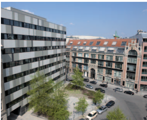
Das Paul-Drude-Institut (links) mit neuer Fassade
